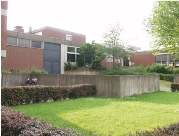
Heizzentrale von außen Quelle: EAM EnergiePlus GmbH
