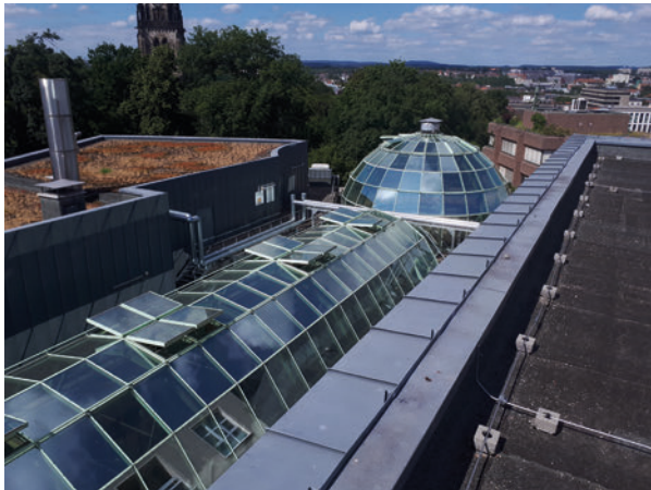
Kuppeldach Quelle: Städtische Werke AG
